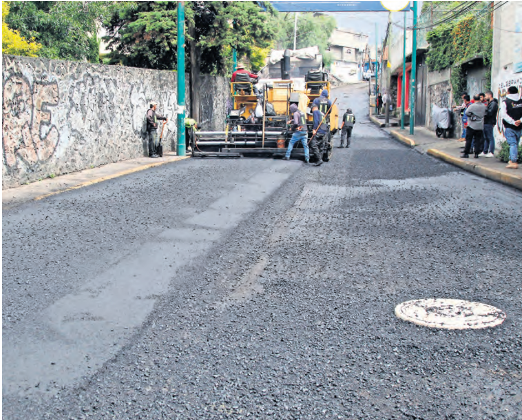
La alcaldía Tlalpan inició trabajos de reencarpentamiento en Fuentes del Pedregal, la obra más importante que haremos este año.
